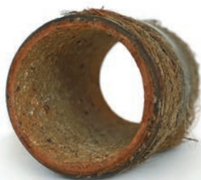
ohne Schutz, verrostetes Heizungsrohr mit Magnetitablagerungen
